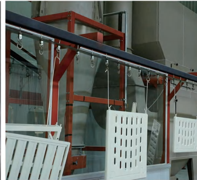
全自动喷涂生产线 Automatic Painting production line
